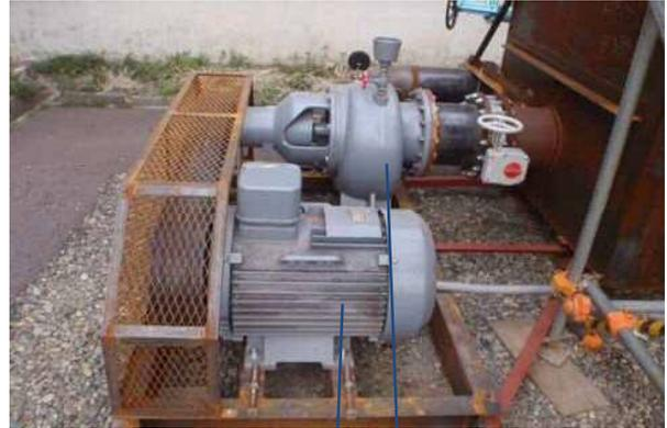
45KW6P 電動機
