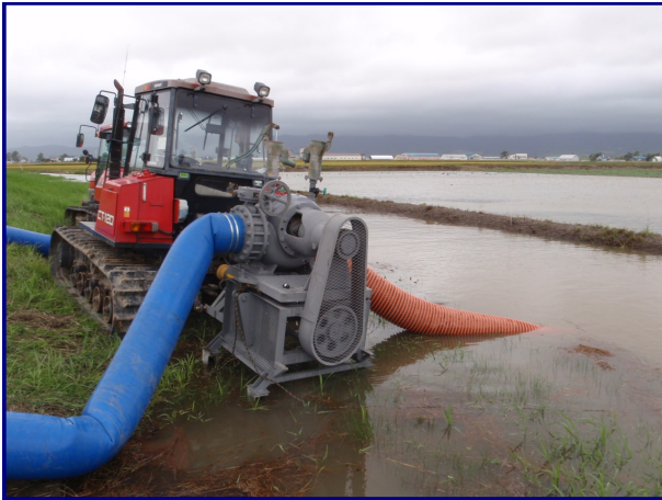
排水ポンプ設置状況
