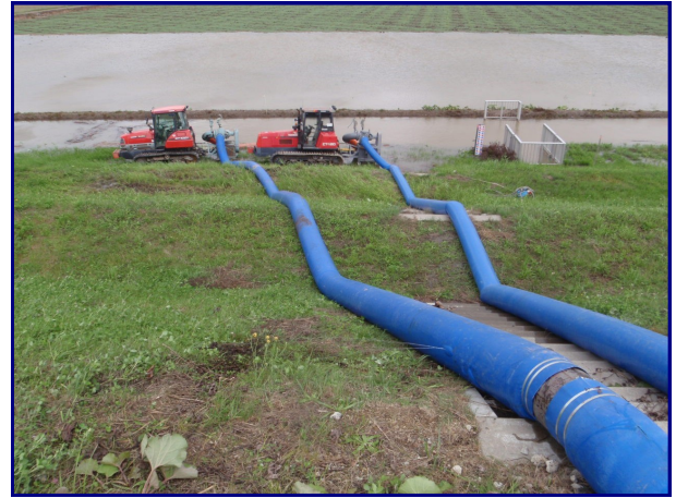
ホース敷設状況
