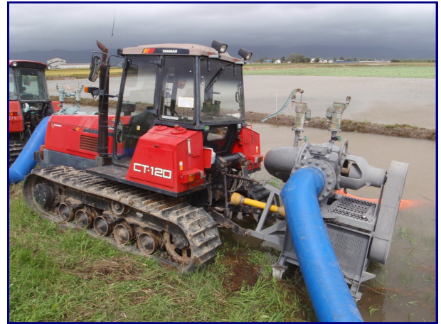
排水ポンプ設置状況
